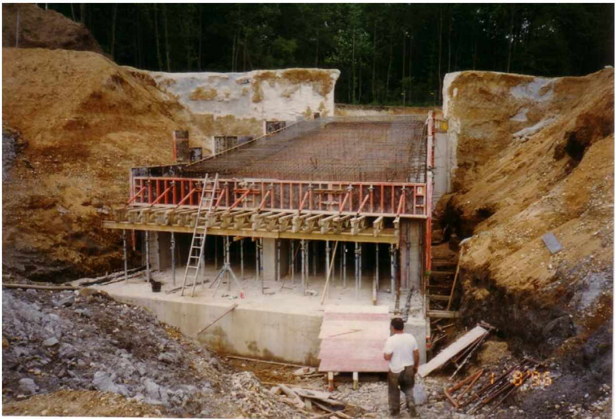
Zwischenbauzustand des Einlaufbauwerkes
