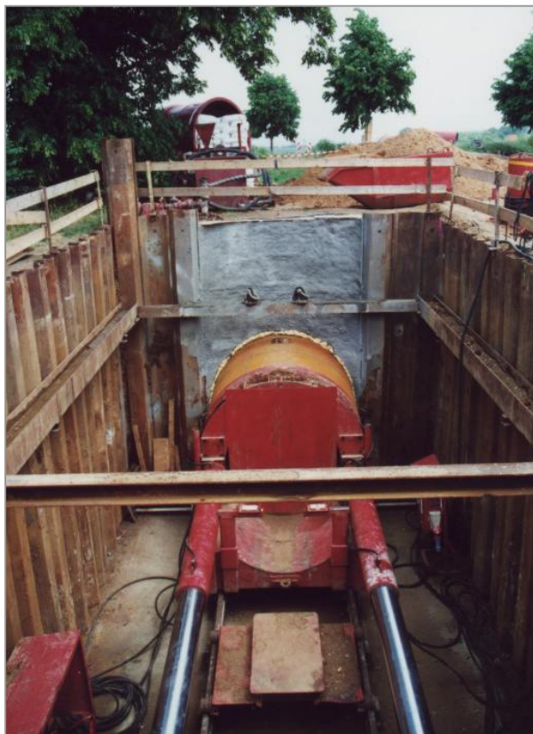
Vortrieb DN 2000 Spannbeton
